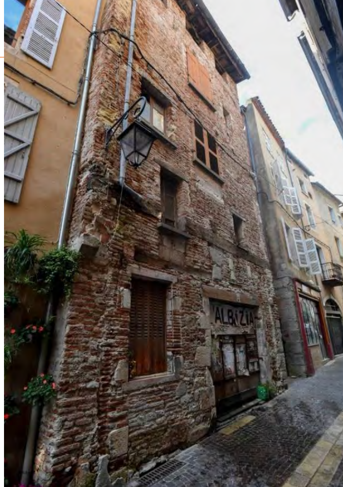
Chantier école à Cahors, démarche Enerpat
