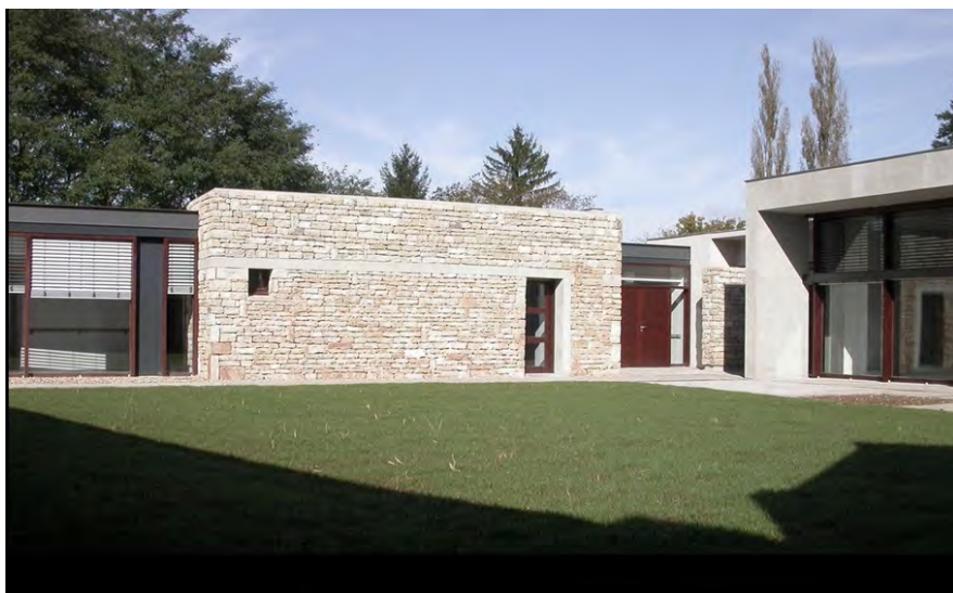
Maison d'accueil rurale pour des personnes âgées à Pesmes (70), Malcotti Roussey, architectes à Luxeuil-les-Bains
